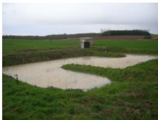
Figure 4 : Dispositif « mare-tampon en S »
