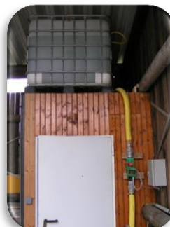
Cuve tampon de volume inférieur à la cuve du pulvérisateur
